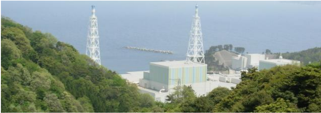
（中国電力島根原子力発電所）
